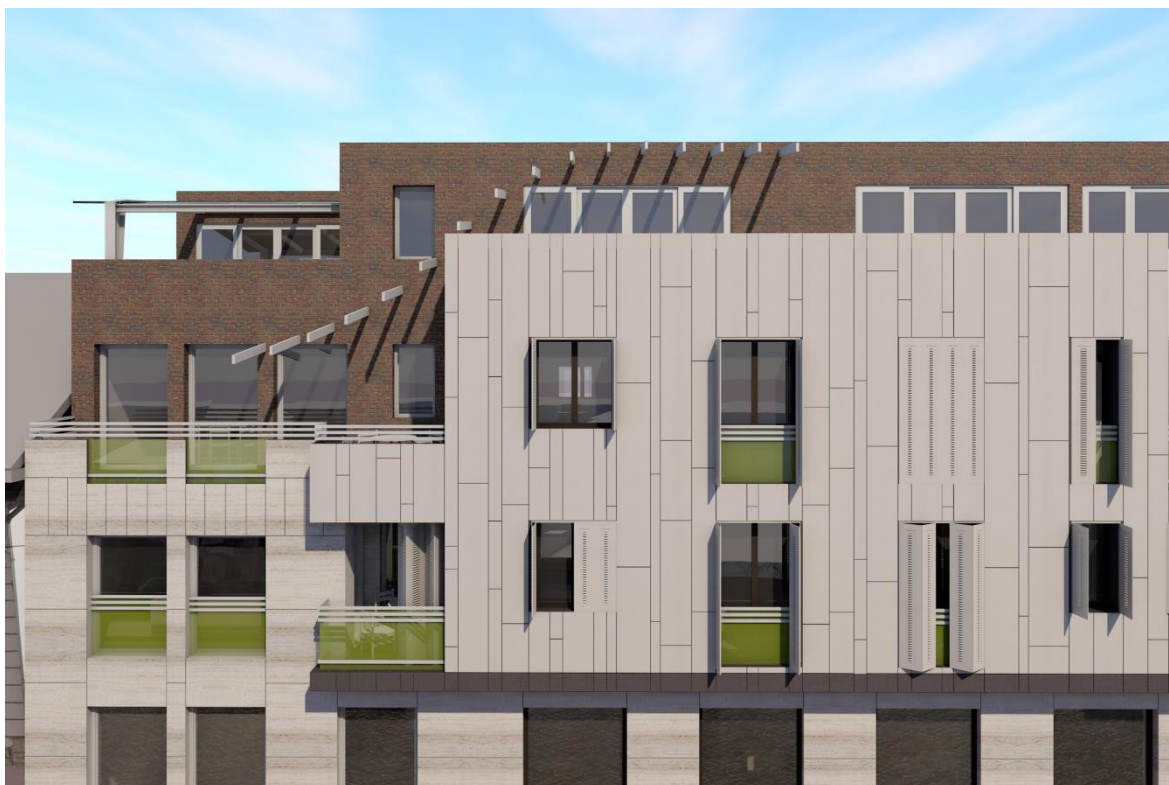
_ az új épület homlokzati részletei, homlokzati burkolóelemek és pergola nappal
